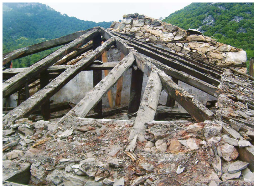
Στην ανακατασκευή της στέγης χρησιμοποιήθηκαν παλαιές σχιστόπλακες και μια σειρά σύγχρονων υλικών υγρομόνωσης και θερμομόνωσης.
