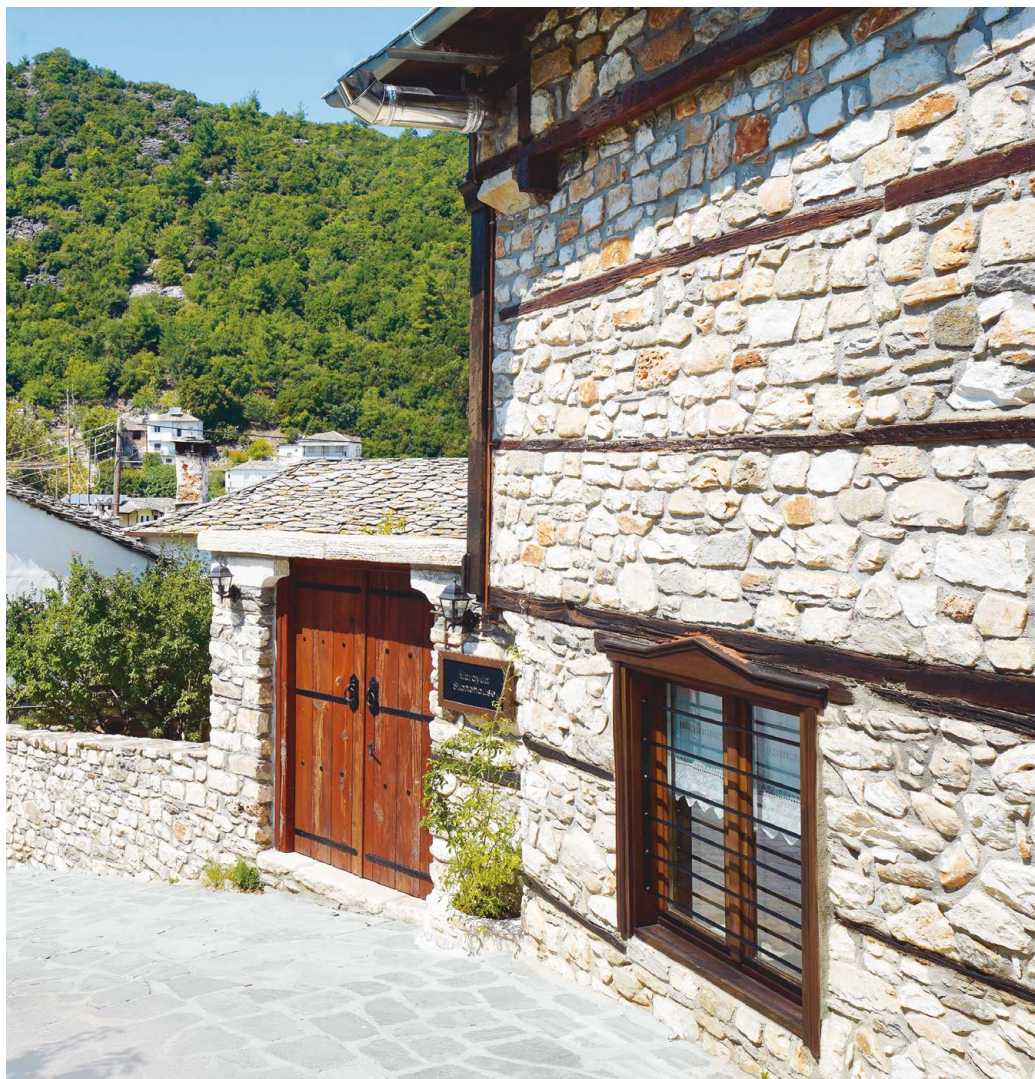
Η κατοικία αναπτύσσεται σε επικλινές επίπεδο, με ένα μέρος του ισόγειου χώρου να βρίσκεται κάτω από τη στάθμη φυσικού εδάφους.
