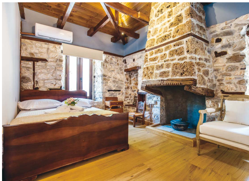
Η καμινάδα του μεγάλου τζακιού ανακατασκευάστηκε από πωρόλιθο για μείωση του βάρους.
