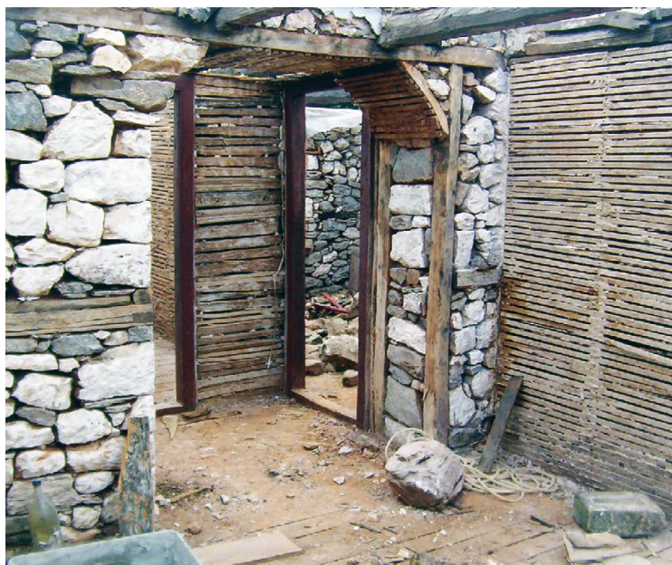
Τα βασικά δομικά υλικά της αρχικής δομής διατηρήθηκαν στο ακέραιο. Το νέο ξύλινο πάτωμα "πάτησε" επάνω στα υπάρχοντα ξύλινα δοκάρια.
