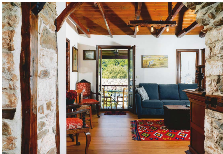
Εσωτερικά της στέγης τα ξύλινα ζευκτά παραμένουν εμφανή.
